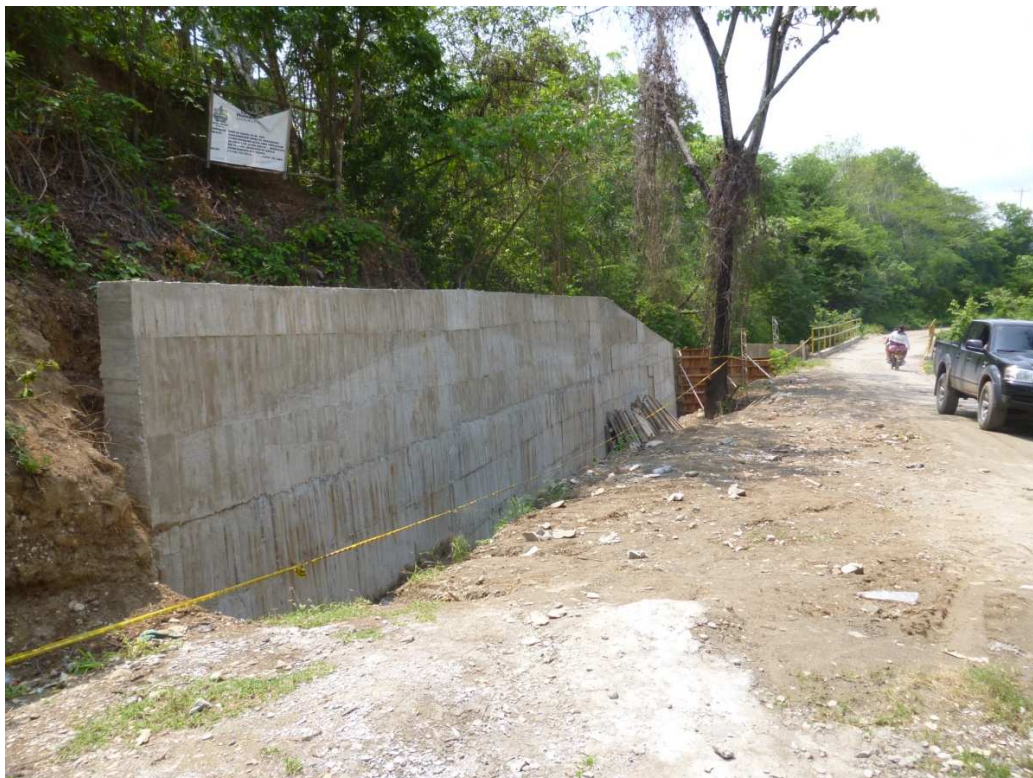
CONSTRUCCION MURO DE CONTENSION Y PROLONGACION ALETA PARA PROTECCION DEL PUENTE EN LA VIA COELLO-BARRIALOSA- COLOMBIA HUMANITARIA
