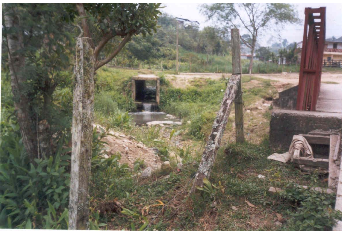
FOTO 10. Estructura hidráulica (box coulvert) ubicado en el sector de la playita.
