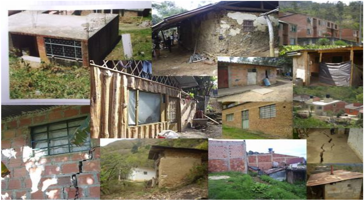
Viviendas de Guateque - Boyacá. Fuente. Ingeniero William Alejandro Neira Zambrano
