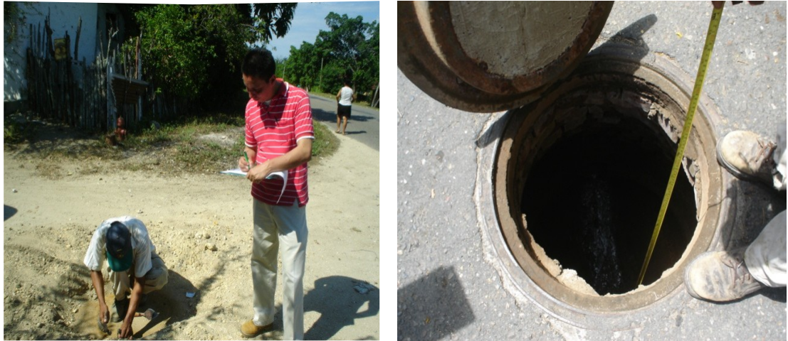
Foto 5 - 6. Características físicas y estructurales de los pozos Inspección directa de pozos.
