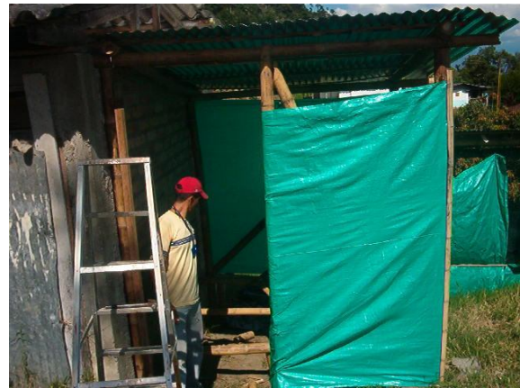
Construcción de caseta de aprovechamiento Matecaña
