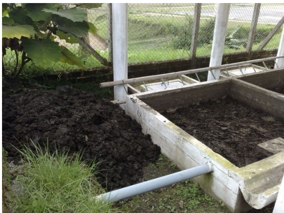
Foto lechos de secado y almacenamiento de los lodos provenientes de la PTAR
