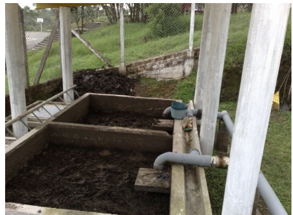
Foto lechos de secado y almacenamiento de los lodos provenientes de la PTAR
