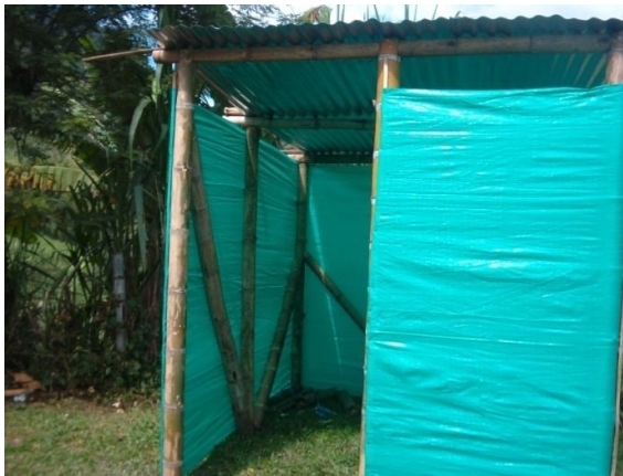
Construcción de caseta de aprovechamiento Moreta
