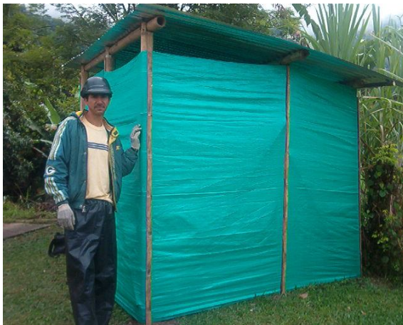
Construcción de caseta de aprovechamiento Cto Santa Elena
