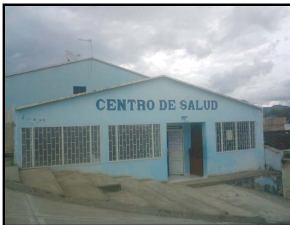
Centro de Salud Cabecera Municipal, Febrero de 2008. Fuente: Dirección Local de Salud
