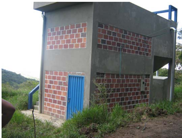
Fotografía Planta de Tratamiento de Agua Potable Rural
