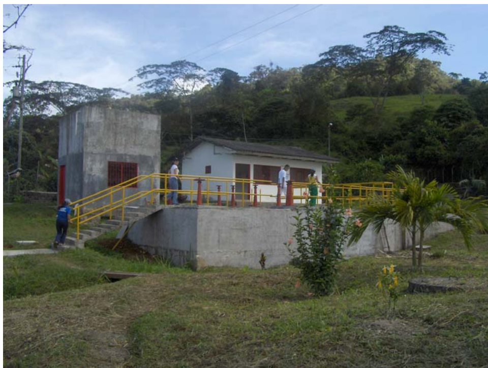
PLANTA DE TRATAMIENTO DE AGUA POTABLE MUNICIPIO DE SAN FRANCISCO
