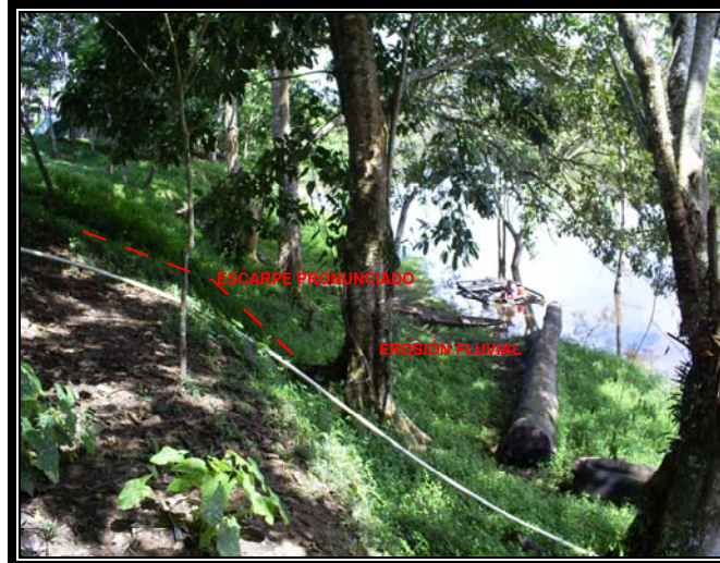
Figura 43. Escarpes erosivos en la comunidad de San Juan de Socó.
