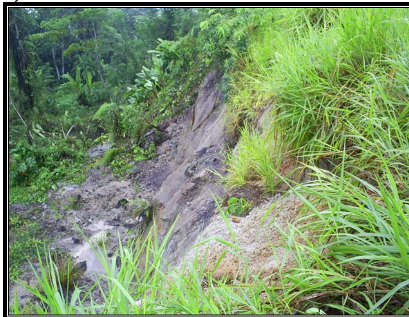
Figura 47. Deslizamiento de tipo planar localizado en la parte alta de la parcialidad de Patrullero.
