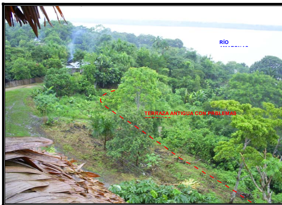
Figura 46. Problemas erosivos en la parcialidad de Veinte de Julio.
