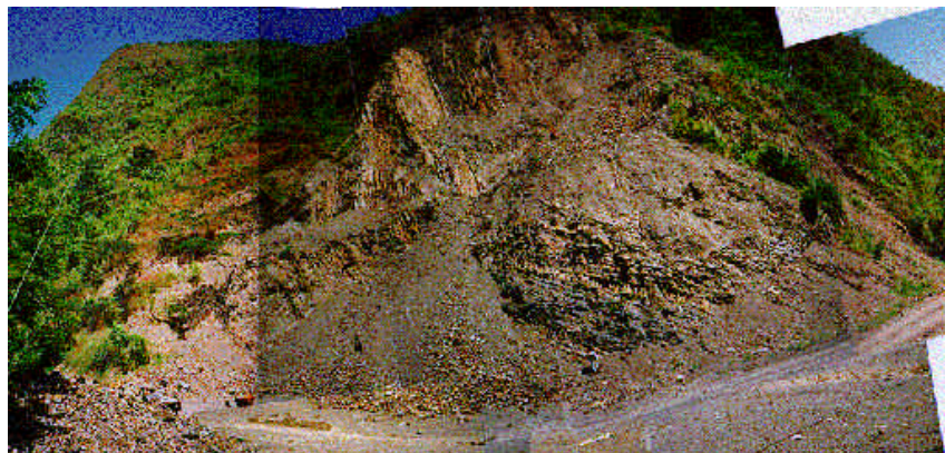
Figura N° 12. Cantera en el sector El Volador
