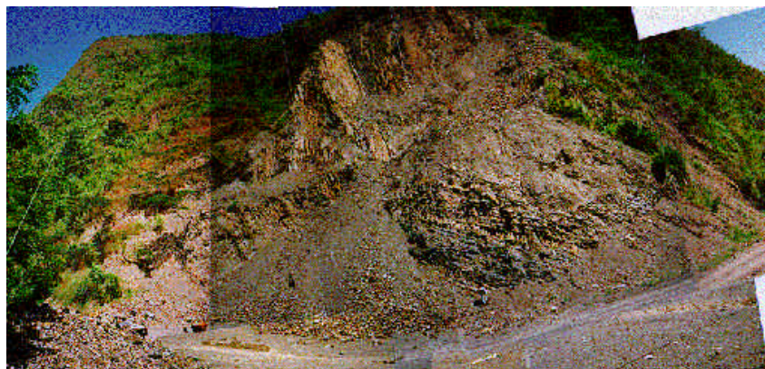
Figura N° 12. Cantera en el sector El Volador
