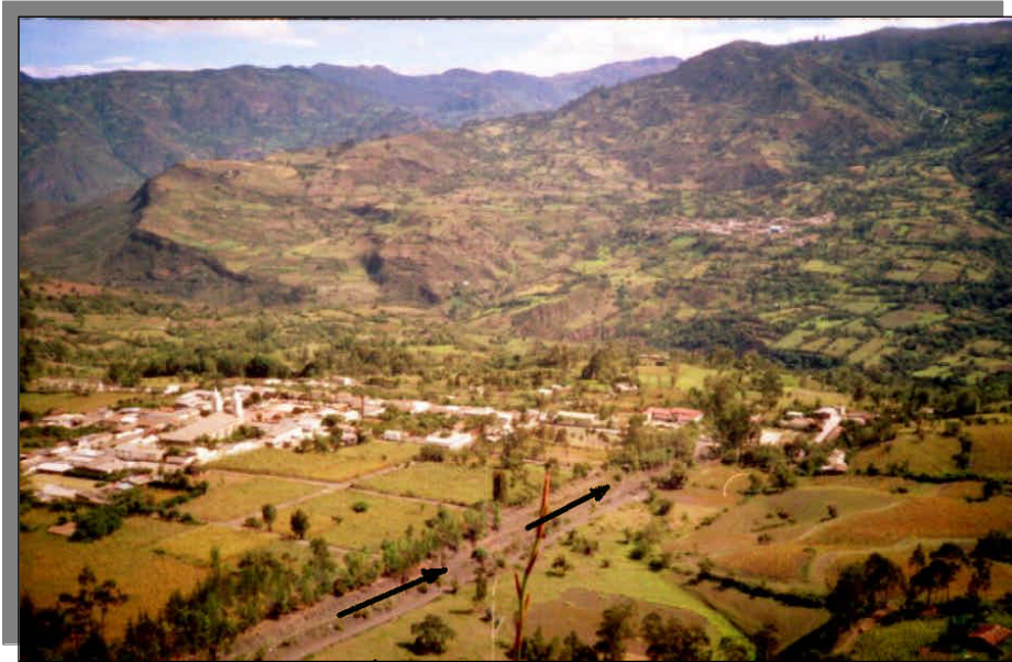
Fotografía 8.2. Situación de riesgo por causa de la Quebrada Surcabásiga
