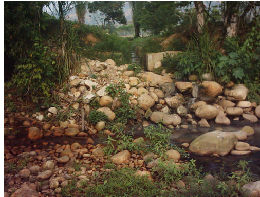
Aguas Negras Vertidas por medio de un canal Al río Tocaría sin ningún tratamiento, del casco urbano del municipio, causando mal olor y presencia de animales carroñeros en el brazo del río.
