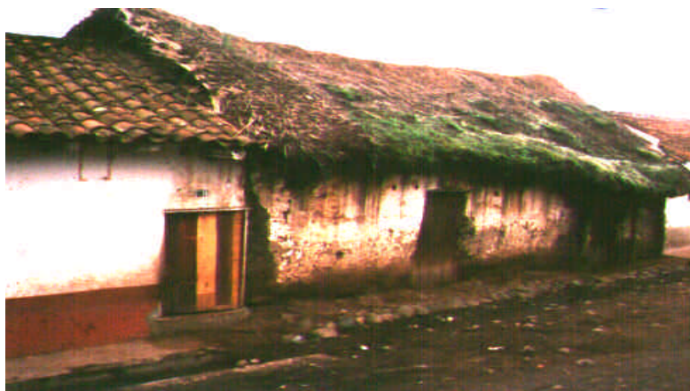
FIGURA No. 10. VIVIENDA CONSTRUIDA EN BARHEQUE
