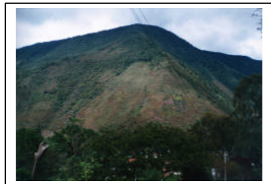
FOTO N. 29 PANORÁMICA DE LADERAS EROSIONALES EN LA VEREDA ESPARTA.
