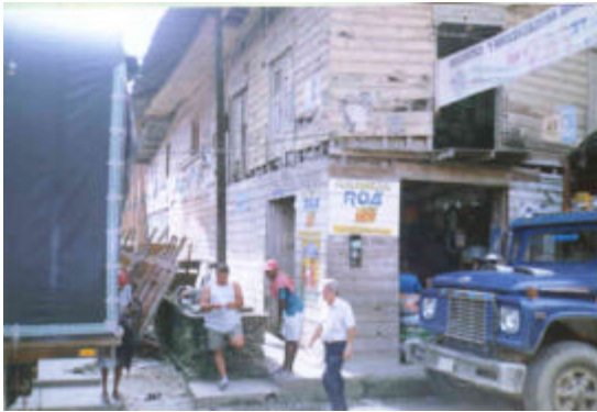
Construcciones viejas que amenazan ruina Descargue en horas de alto trafico
