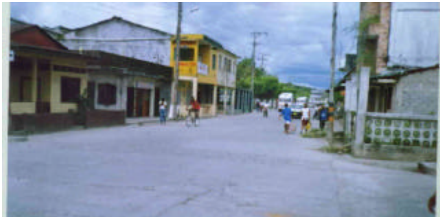
Falta de andenes para los peatones
