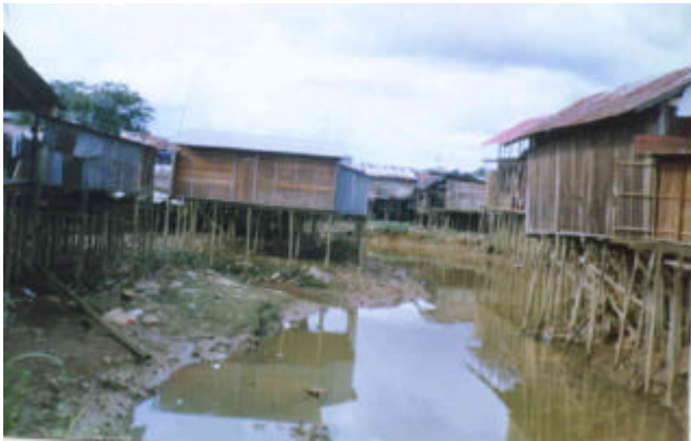
Construcción en las rondas de los ríos.
