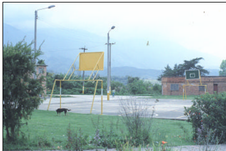
Figura 55. Polideportivo localizado en el parque Corregimiento La Palma
