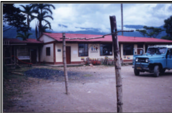
Foto 10: Vista de la escuela Nueva Leones.
