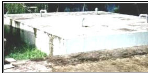
**FOTO 18:** *Tanques almacenamiento enterrados.*
