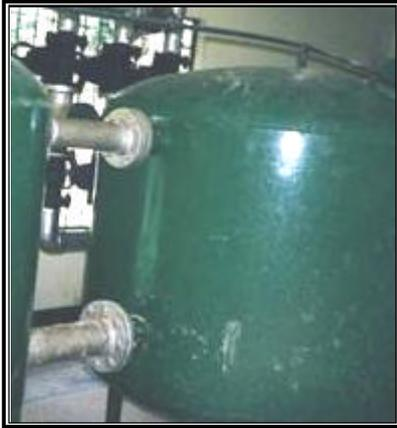
Posee un filtro del tipo por gravedad metálico cuyo material de falso fondo es Arenilla, grados 1, 2 y 3 y Antracita. Es autolavado en buen estado de 1.5 m de radio y 2 metros de alto.
