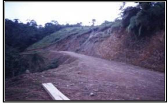
**Foto 3-4:** Movimientos de remoción en masa; fenómenos característicos de las vías veredales debido a la desprotección de los taludes y falta de obras de arte, factores que inestabilizan el terreno en épocas de alta precipitación.
