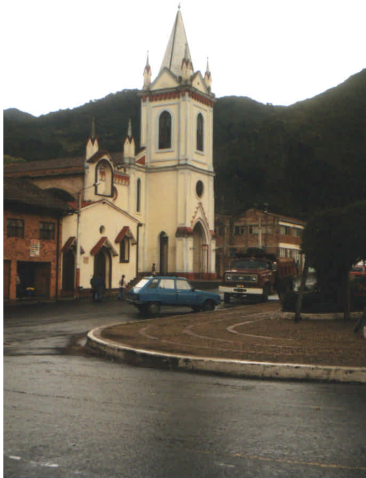
FIGURA E2-3. Iglesia de Arcabuco.
