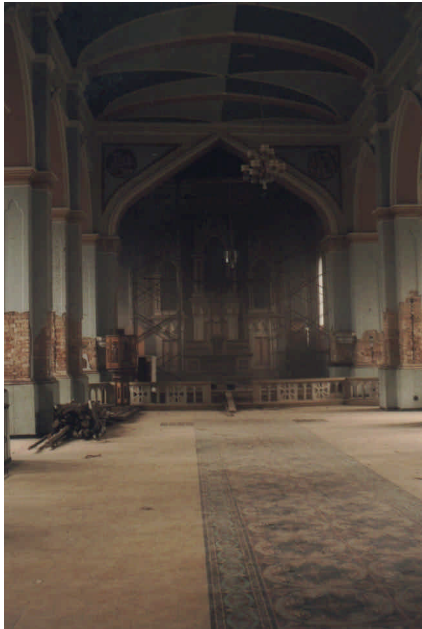
FIGURA E2-5. Fotografía de la nave central de la Iglesia.
