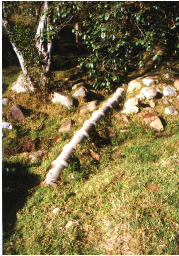
FIGURA B2-4. Punto de vertimiento de alcantarillado al río Arcabuco.
