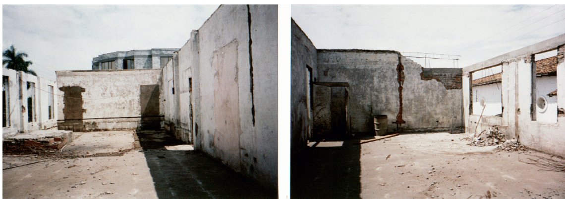
Foto 5 y 6 Alcaldía Municipal (en construcción)
