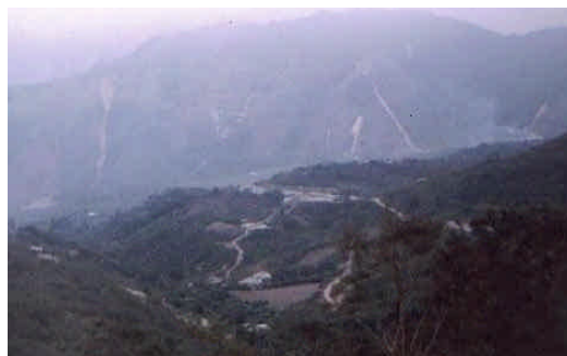
Foto 3. Panorámica de zona de inestabilidad del terreno que presenta fenómenos de remoción de masa tales como deslizamientos, flujos de tierra y erosión.
