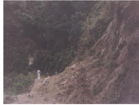
Foto. Deslizamiento local producto de la acción de la falla geológica que inestabilizo el terreno de la unidad sedimentaria cerca de la quebrada de los trabajos, presentando buzamientos encontrados, alta fracturación de los estratos y cambios litológicos de areniscas con calizas intercalados con shale.
