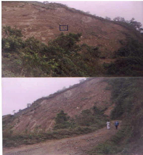
Foto . Deslizamiento de gran magnitud sobre la carretera que conduce a la vereda Torcorama, debido a la alta meteorización y acción de la carcaní de la falla que pone en contacto a la unidad sedimentaria con la unidad ígneo – metamórfico acompañado de un mal uso del suelo que generan fenómenos de remoción en masa.
