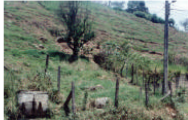
FOTO No. 27 Erosión en forma de escalones denominada pata de vaca. Sector Las Mercedes. En la parte baja muro de contención para protección del talud.
