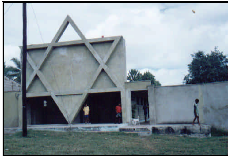
FOTOGRAFÍA 57. CENTRO DE REHABILITACIÓN PARA NIÑOS Y JÓVENES "JESÚS SALVADOR" UBICADO EN LA VIA A POLONUEVO
