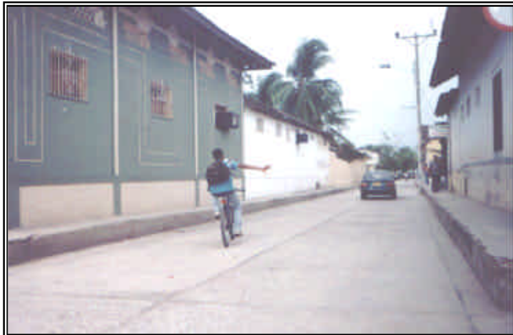
FOTOGRAFÍA No. 22. CRA. 11 - CALLES 5 PAVIMENTO REGULAR, VÍAS ANGOSTAS, ANDENES MÍNIMOS, LO QUE NO PERMITE ARBORIZAR Y POCA SEGURIDAD AL PEATÓN
