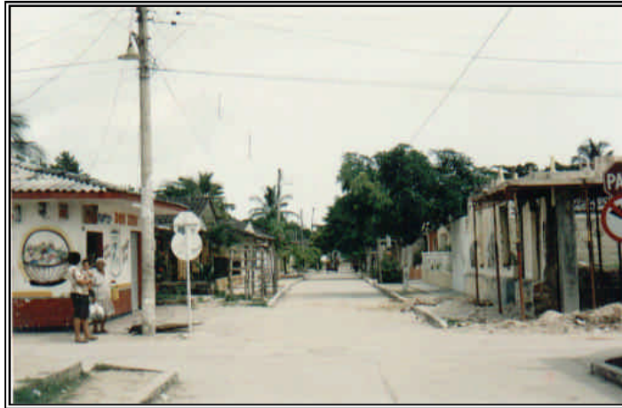
FOTOGRAFÍA 17. CALLE 4 - CRA. 13 NÓTESE LOS DIFERENTES ANCHOS DE VÍAS Y LA INEXISTENCIA DE ZONA DE JARDINES
