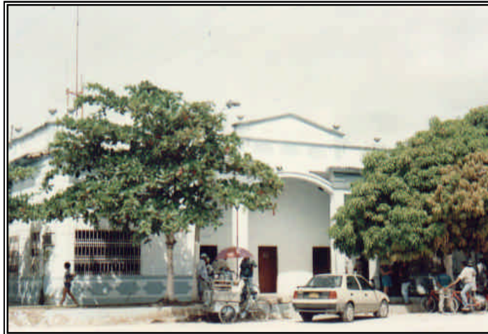
FOTOGRAFÍA No. 50. CALLE 3 CRA 11 EDIFICIO DE LA ALCALDIA
