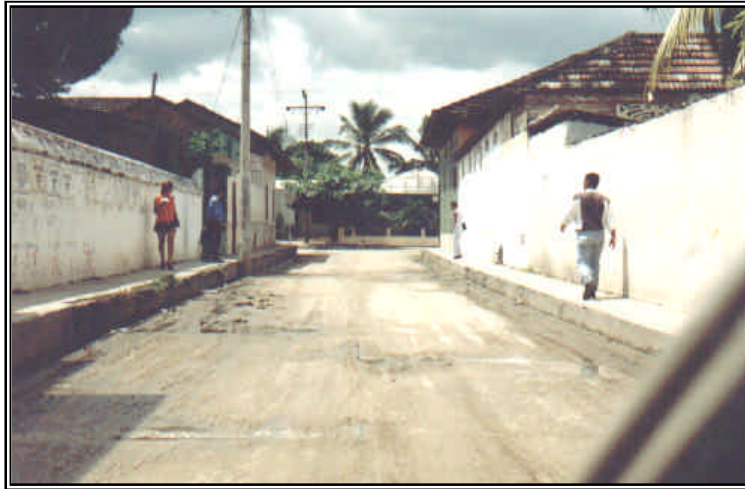
FOTOGRAFÍA No. 21. CRA. 11 - ENTRE CALLES 4 Y 5 PAVIMENTO REGULAR, VÍAS ANGOSTAS, ANDENES MÍNIMOS, LO QUE NO PERMITE ARBORIZAR Y POCA SEGURIDAD AL PEATÓN
