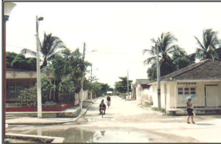
FOTOGRAFÍA 23. CALLE 3 – CRA. 10 VÍAS ANGOSTAS, ANDENES MÍNIMOS, NO PERMITE ARBORIZAR AGUAS ESTANCADAS POR NIVELES INADECUADOS
