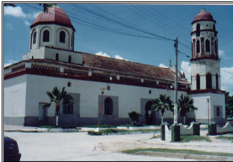
FOTOGRAFÍA No. 47. PLAZA PRINCIPAL IGLESIA SANTO TOMÁS DE VILLANUEVA
