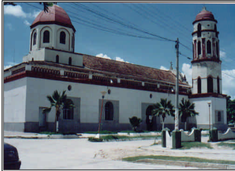
FOTOGRAFÍA No. 34 IGLESIA SANTO TOMÁS DE VILLANUEVA. UBICADA EN LA PLAZA PRINCIPAL
