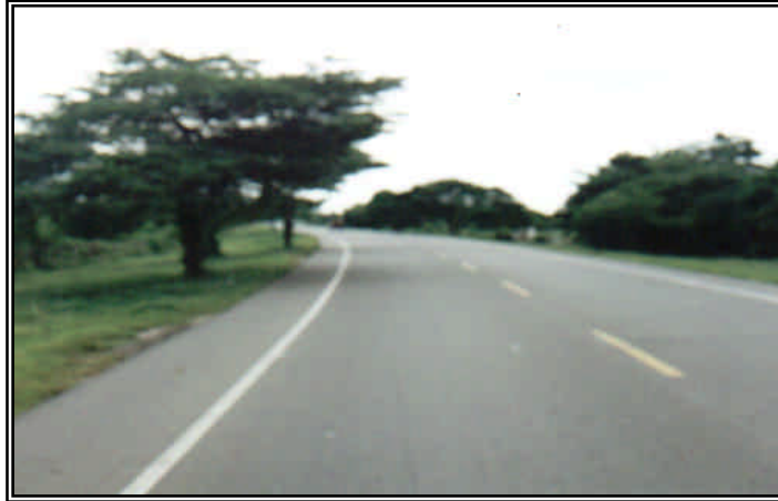
FOTOGRAFÍA 15. ENTRADA AL MUNICIPIO POR LA CARRETERA ORIENTAL
