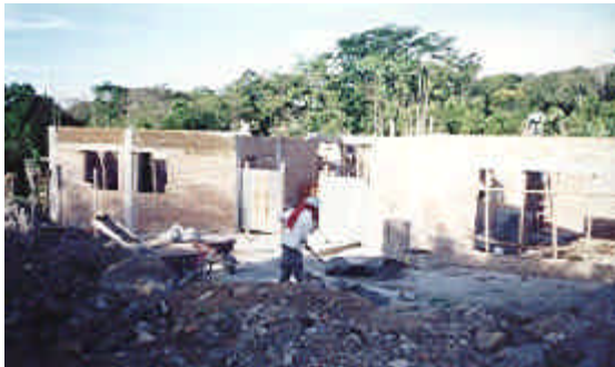
Foto 1-127 Centro comunitario de Alpujarra en construcción
