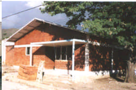
Foto 1-133 Casa Fiscal en reconstrucción
