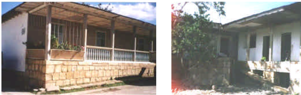
Foto 1-88, 1-89 Fachada Principal y solar interior de la vivienda de María Amada Osorio. Obsérvese el barandal y el muro de mampostería al interior se destaca la alberca y los cimientos en piedra labrada. Aún cuando las columnas en concreto.
