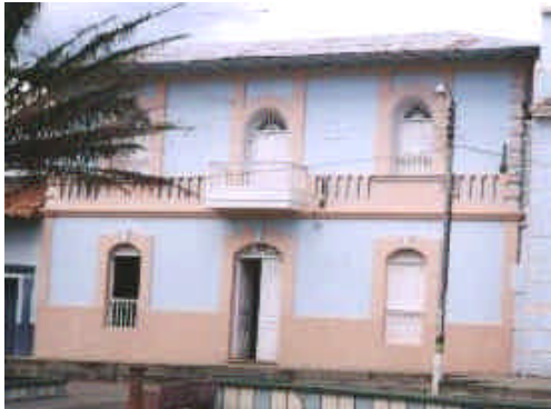
Fotos 1-93 y 1-94 Fachada Principal y vista interior de la casa cural. Obsérvese el balcón central, las puertas y ventanas en madera pero techo 3n zinc al interior nótese las columnas, escaleras y pasamanos y pisos en madera
