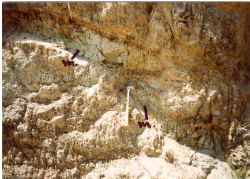
FOTO No. 6: Falla en la vía hacia cabecera de la quebrada la Caima. Nótese milonitización por el desplazamiento relativo del bloque.
