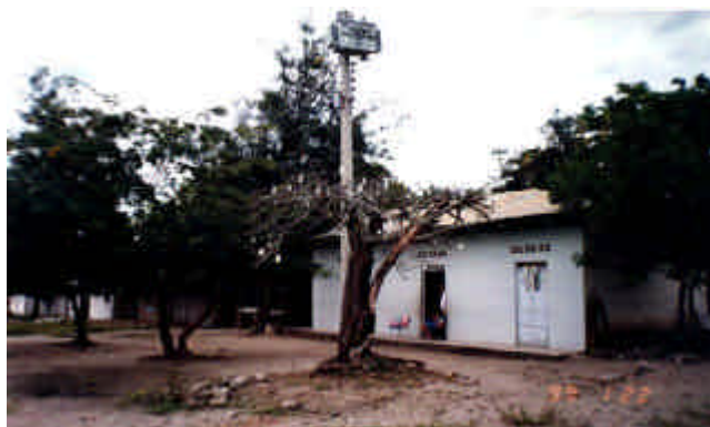
Foto 4. Transformador. Red de Energía de Alta de la Vereda La Palmita
