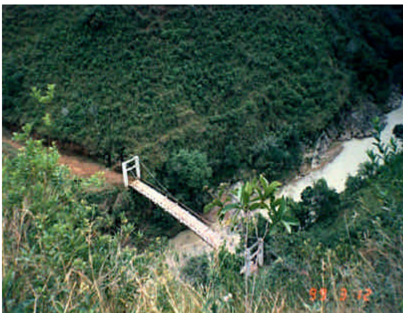
Foto 1. Río Anchique. Puente sobre el Río Anchique, ubicado entre los Municipios de Natagaima y Ataco.
