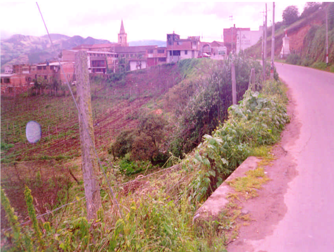
FOTOGRAFÍA 1.12. El relicto de bosque existente al lado de la vía, corresponde con un nacimiento de agua que hacia la parte baja (Lote “La Mana”) no es controlado (drenaje deficiente) provocando los encharcamientos por mal manejo del agua a escasos doscientos metros del parque principal.
