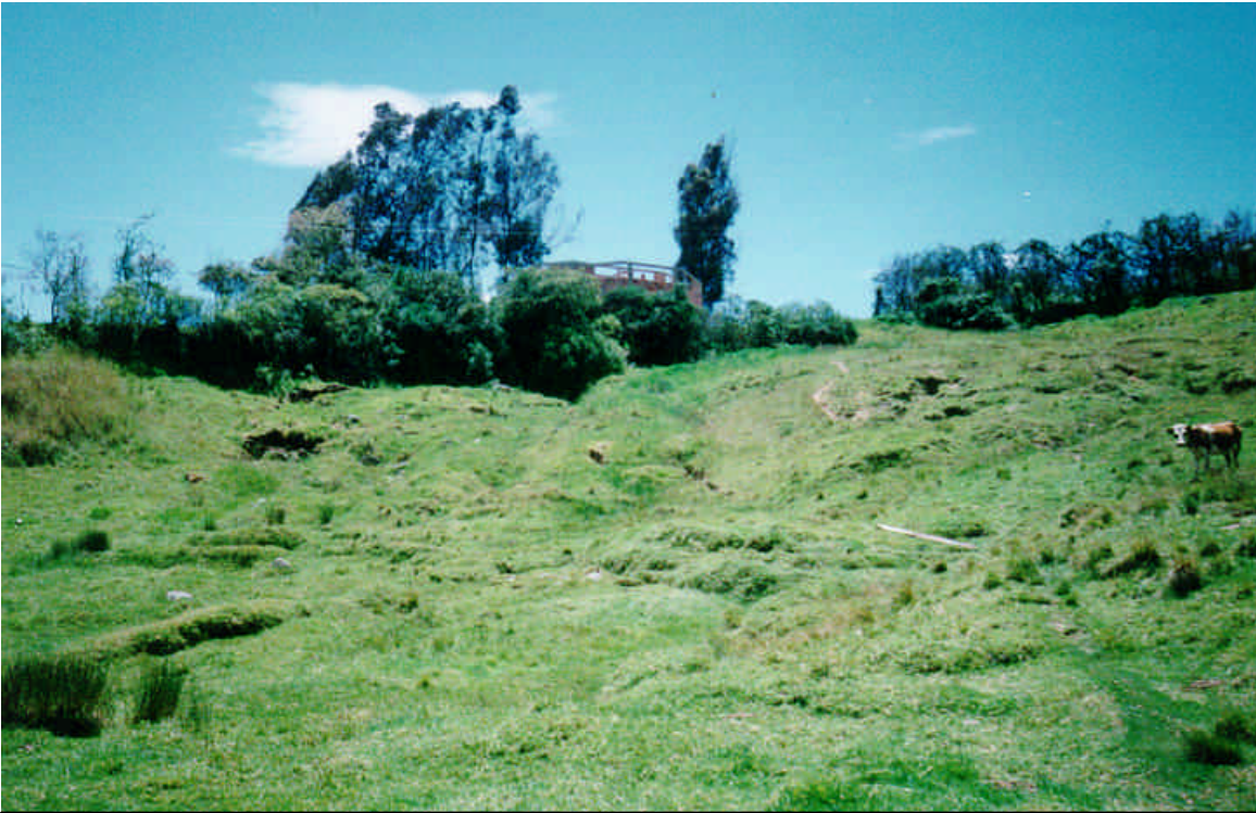
FOTOGRAFIA 1.7. Masa en reptación que amenaza con destruir el Salón Comunal de Tejar Arriba.
