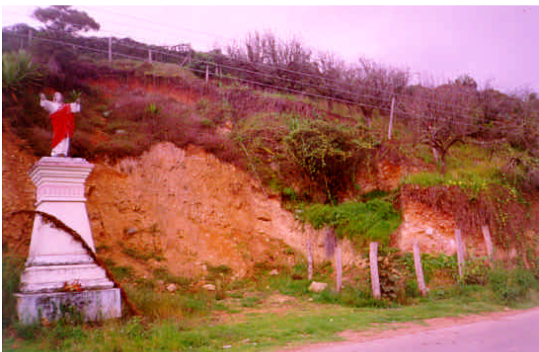
FOTOGRAFIA 1.10. Deslizamiento ubicado en el casco urbano, ha sido acelerado por la extracción de materiales de construcción del pasado. Nótese la grieta en la corona y el movimiento del material hacia la vía.
