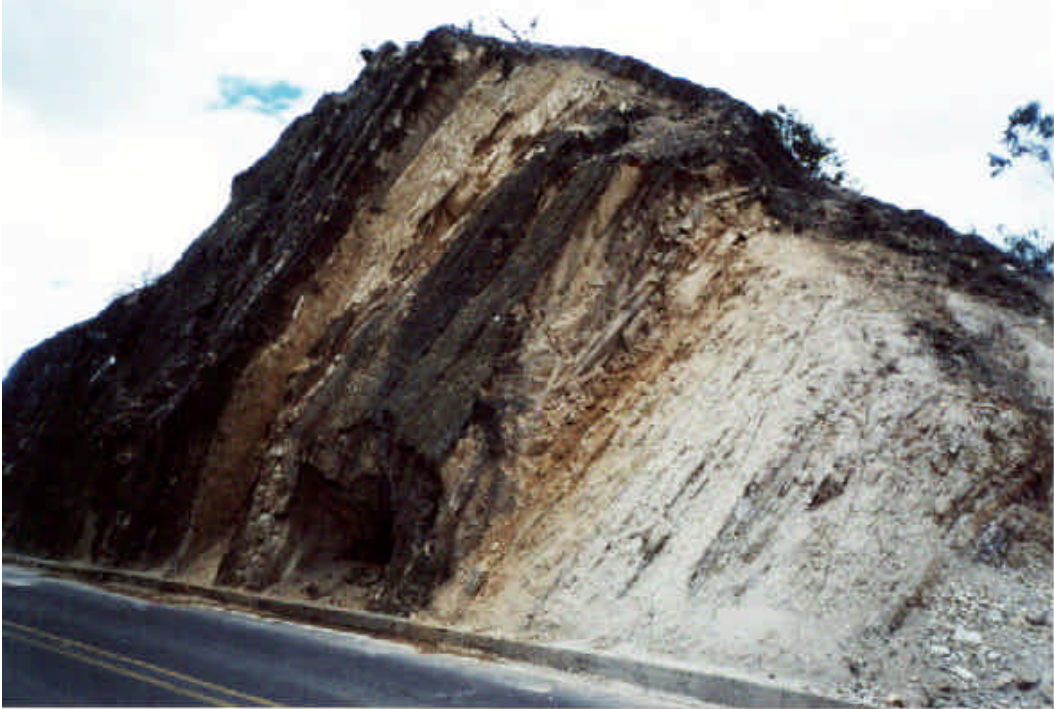
Fotografía 1. Aspecto de las rocas de la Formación Conejo que se perciben a lo largo de la vía Tunja – Cucaita. Nótese la secuencia estratigráfica de lodolitas arcillolitas y areniscas deleznales, susceptibles a generar procesos de erosión concentrada.
