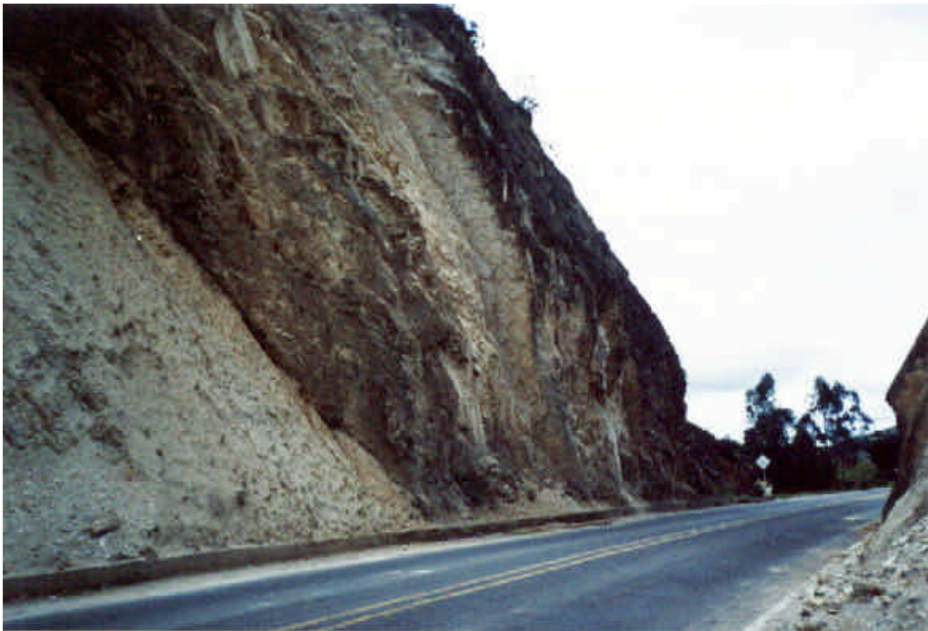
Fotografía 2. Otro aspecto de las rocas de la Formación Conejo (Kscn) en la vía Tunja – Cucaita. En la pata del talud generalmente se acumulan depósitos de talus producto de los flujos de detritos ocasionados por las lluvias torrenciales.
