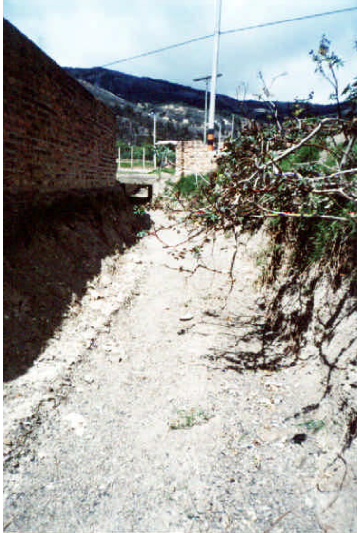
Fotografía 15. Otro de los cauces de las quebradas de la región septentrional de Cucaita. Éste atraviesa el casco urbano en donde se encuentra canalizado en un buen tramo.
