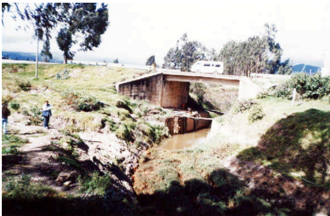
Fotografía 16. Puente Samacá. Aspecto general del Río Gachaneque a su paso por Cucaita: escaso caudal que se aprovecha al máximo para regadío de cultivos. Nótese las motobombas ubicada debajo del puente. Así mismo, la contaminación provocada por el excesivo uso de insumos agrícolas.
