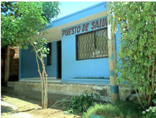
Foto 15. Acondicionamiento del Puesto de Salud del Sector de Las Mercedes.
