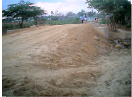
Foto 74. Alcantarilla de la vía hacia Cerrogrande, y Zárate en la salida del casco urbano.
