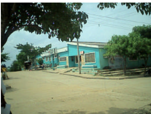
Foto 17. Instalaciones de la ESE Hospital 7 de Agosto.
