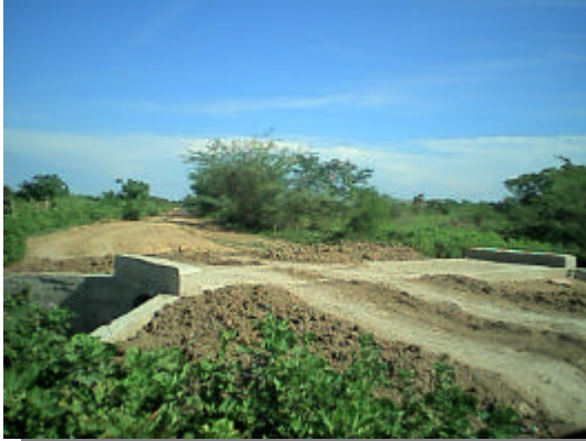
Foto 73. Construcción de alcantarillas en la vía al corregimiento de Cerrogrande.
