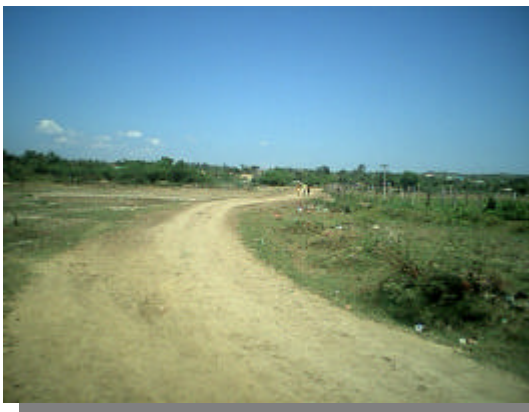
Foto 83. Acceso al sector del dique del caño Plato desde el barrio Luis Carlos Galán.
