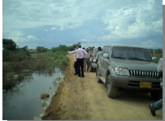
Foto 50. Alcalde recorriendo el dique en tierra en el sector de las ladrilleras.
