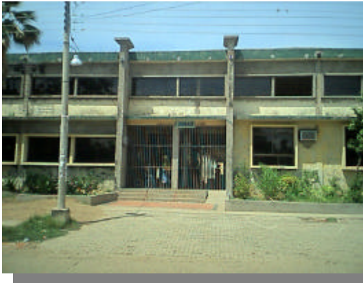
Foto 1. Institución Educativa Juana Benavides antes de la remodelación.
