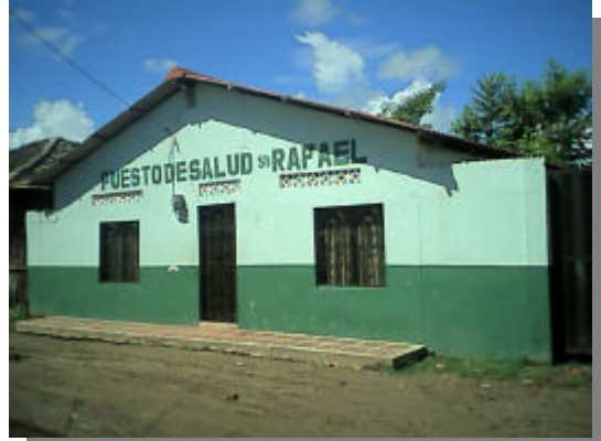
Foto 14. Remodelación del Puesto de Salud del Sector San Rafael.
