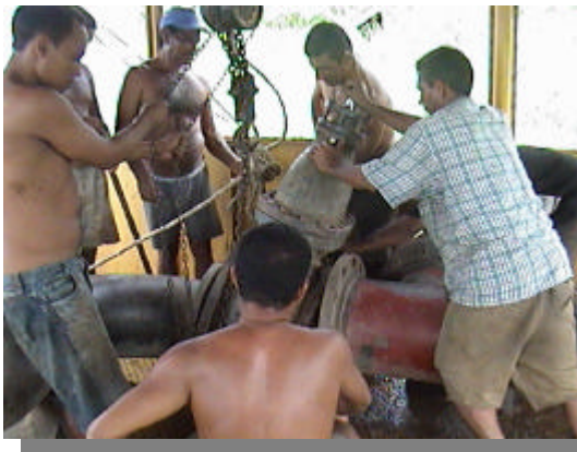
Foto 27. Reparación de válvulas, bombas y motores en las instalaciones del acueducto.
