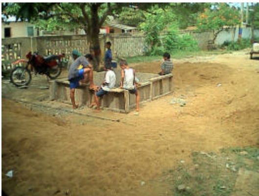
Foto 9. Construcción alberca en la Escuela Mixta Urbana de Varones.
