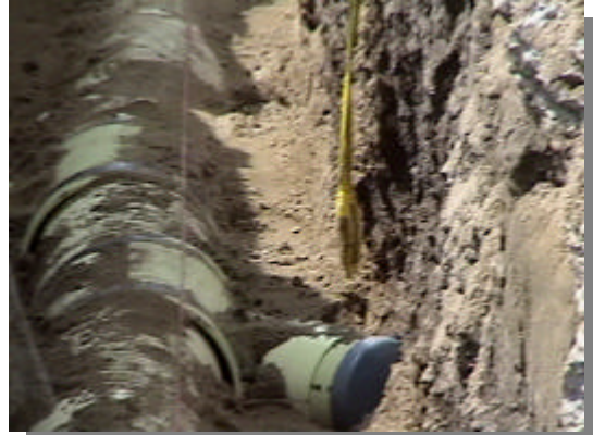
Foto 26. Nueva tubería para el alcantarillado del sector de la carrera 14.
