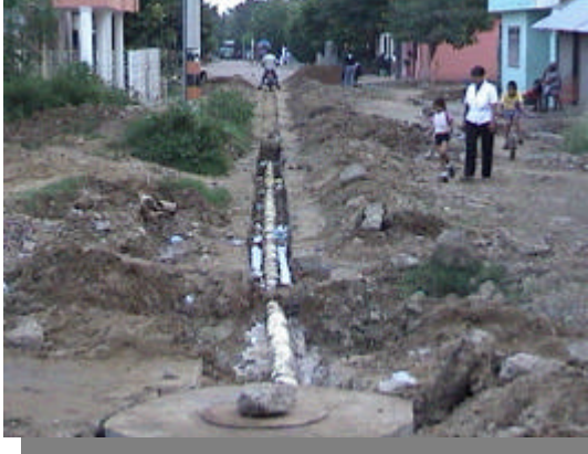
Foto 31. Tubería de alcantarillado en la cabecera municipal.
