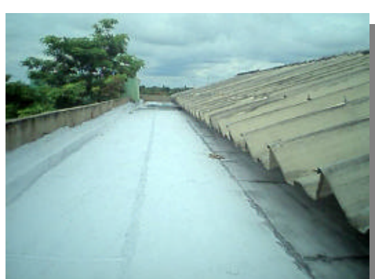
Foto 6. Impermeabilización en la Institución Educativa Luis Carlos Galán.
