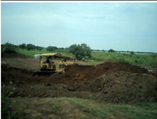
Foto 53. Buldozer Reconfirmando el dique en tierra del Caño Plato.
