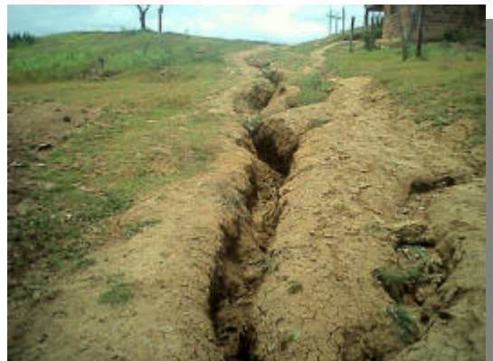
Foto 76. Vista crítica de las vías de acceso al sector de Fredonia.
