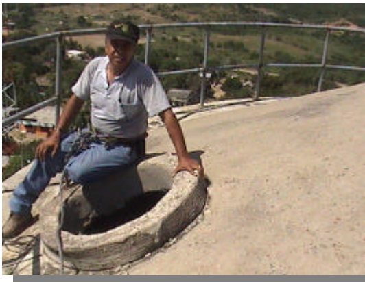
Foto 33. Limpieza y reparación del tanque alto en el barrio Policarpa.
