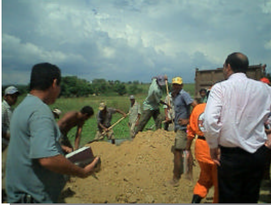
Foto 49. Alcalde dirigiendo la reconfirmación del dique en tierra de Caño Plato.
