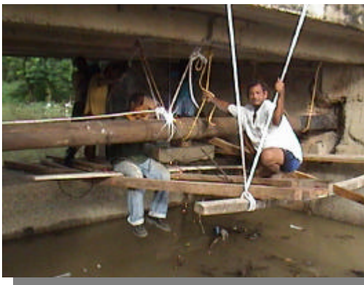
Foto 29. Reparación de la tubería en el puente sobre el arroyo Camargo.
