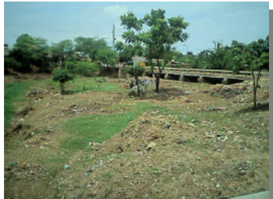
Foto 58. Limpieza del Arroyo Camargo en la carrera 12 entre calles 6 y 7 del casco urbano.
