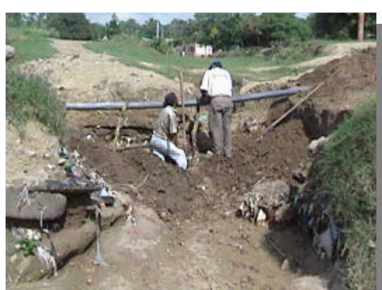
Foto 30. Cambio y reparación de la tubería de conducción de la barcaza en el sector Policarpa.
