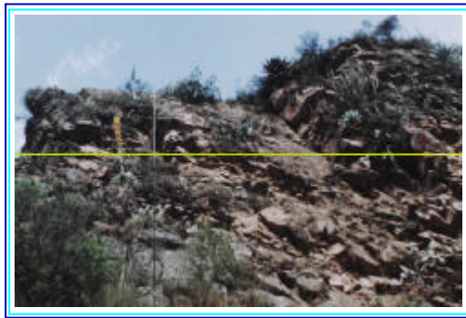
Cobertura degradada - escarpe rocoso - Vereda Alcaparral
