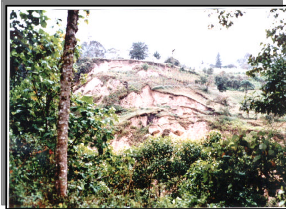
Fotografía No. 3 Panorámica de un movimiento rotacional activo (slump) afectando alas unidades E1.1.de (parte superior) y D1.1.fg (parte inferior). Vereda Quinchos.
