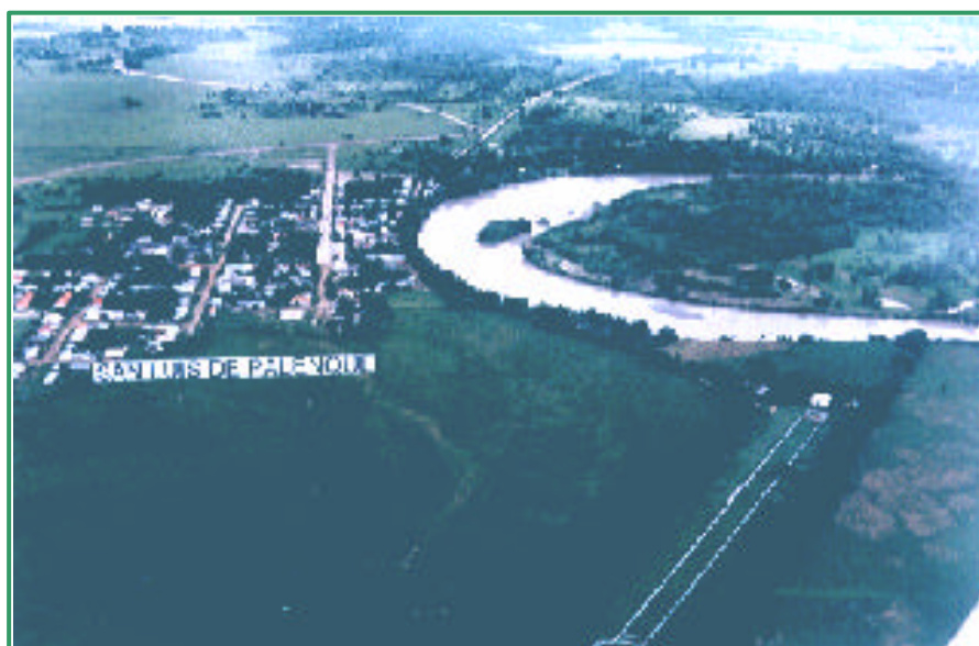
Fotografía 3. Panorámica de la ubicación geológica actual del municipio de San Luis de Palenque, se observa el avance que ha tenido el meandro hacia el casco urbano.
