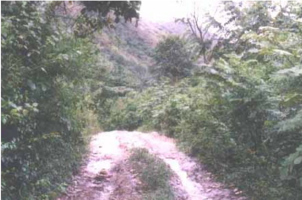
FOTO N° 54. Tramo de la vía en la vereda de Misiones
