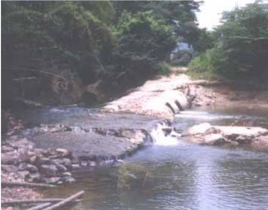
FOTO N° 57. "Puente" sobre la quebrada La Apicalá.
