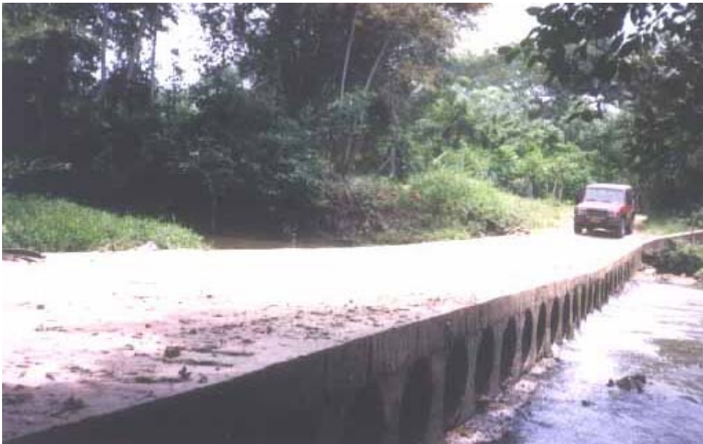
FOTO N° 56. Puente sobre la quebrada La Oloche.
