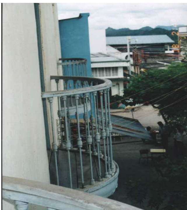
Fotografía 40. Balcón sobre fachada carrera 7 edificio Juzgados y cárcel.
