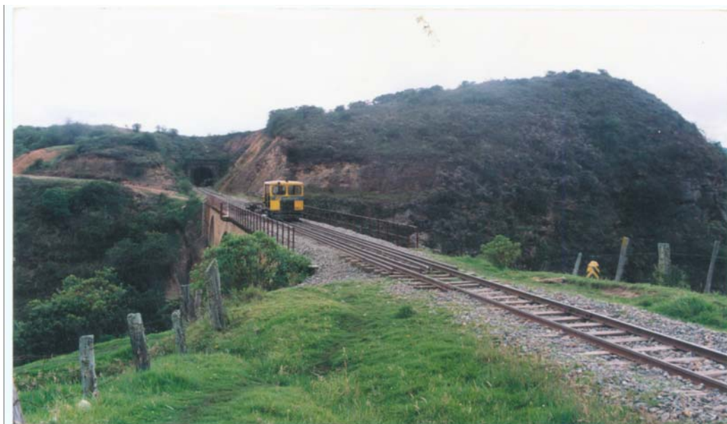
Vía Férrea Sobre el Puente Baurdocci
