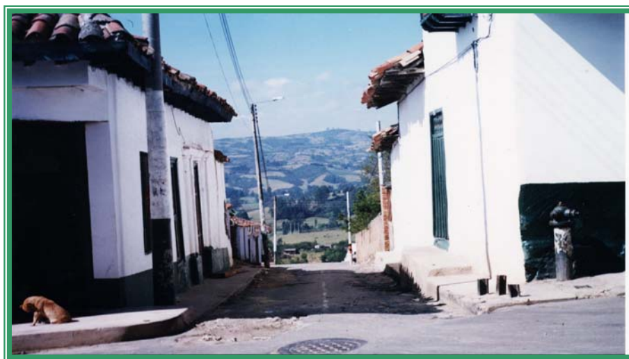
FIGURA No. 68 CALLE 6 ACCESO PRINCIPAL AL PARQUE CENTRAL, VÍA ANGOSTA Y EN MAL ESTADO
