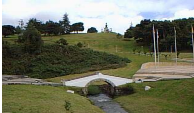
FIGURA No. 12 PUENTE DE BOYACÁ SOBRE EL RÍO TEATINOS
