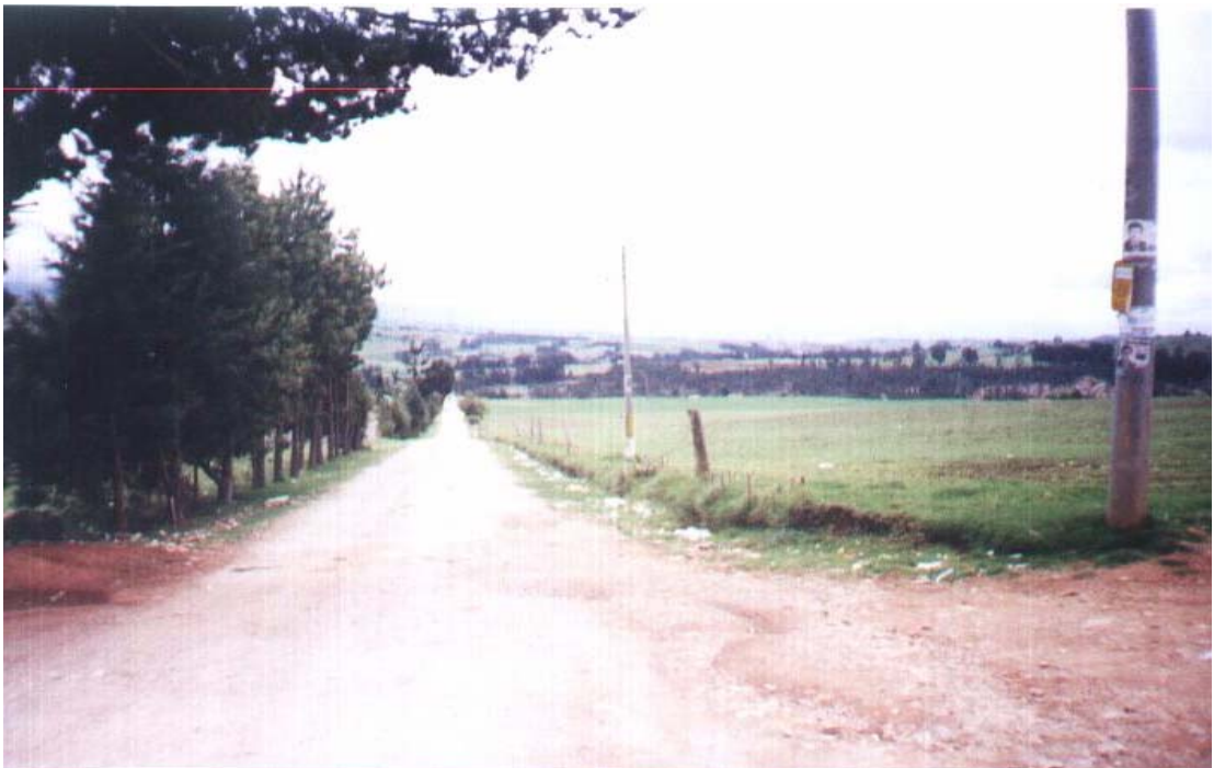
Foto 12 . Estado actual de las vías rurales.
