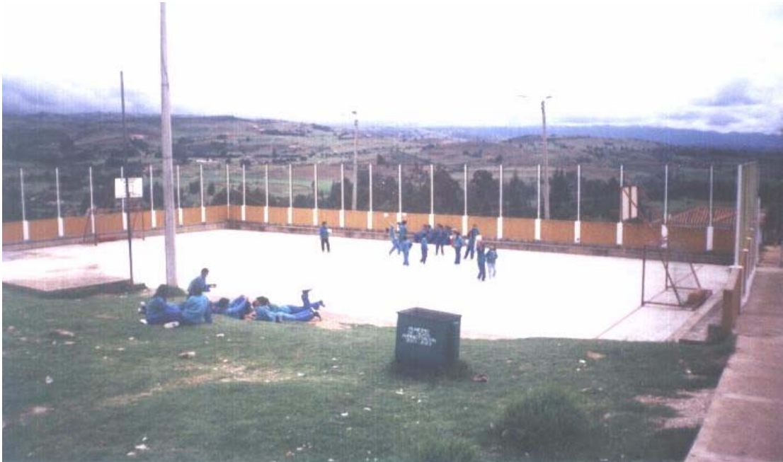
Foto 4. Estado actual de la construcción del Polideportivo en Oicatá.
