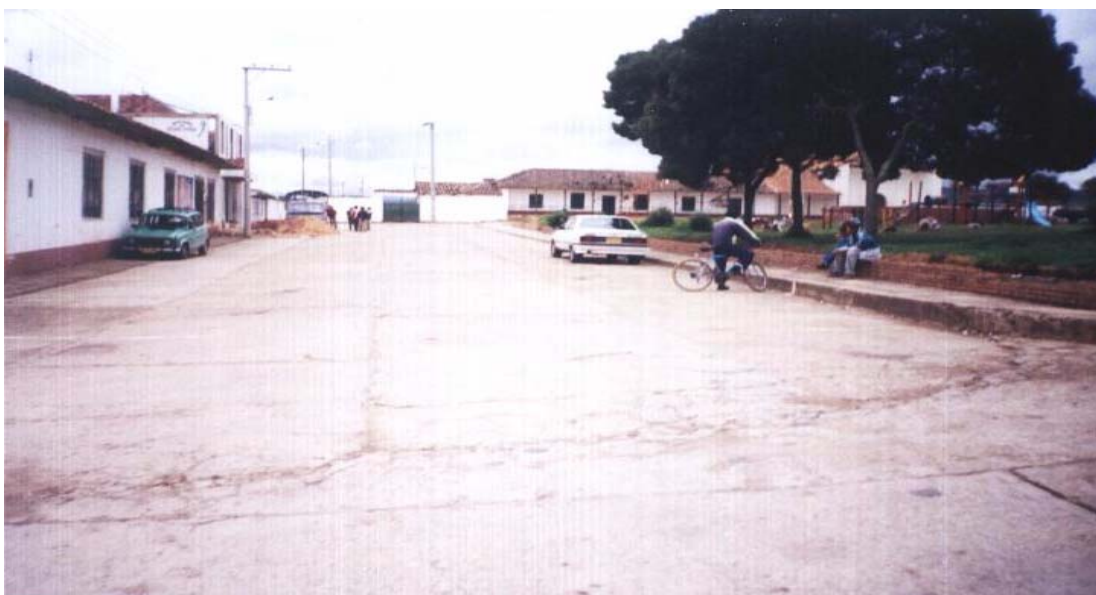
Foto 10. Estado actual vías urbanas
