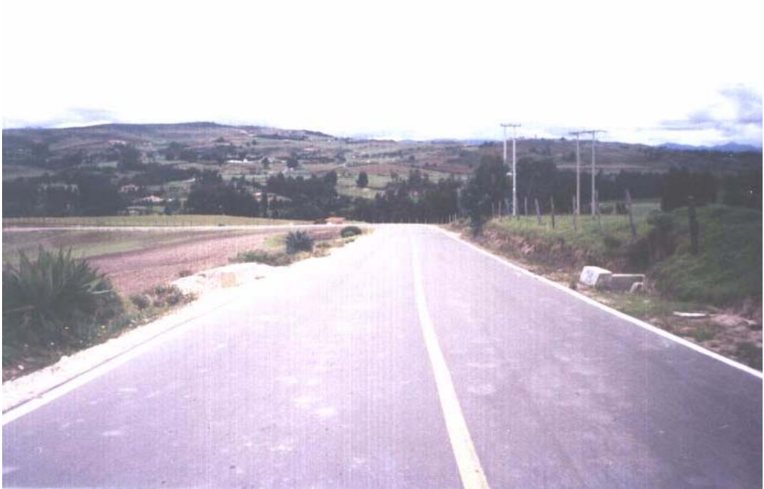
Foto 11. Vía intermunicipal Oicatá – El empalme vía Tunja – Paipa
