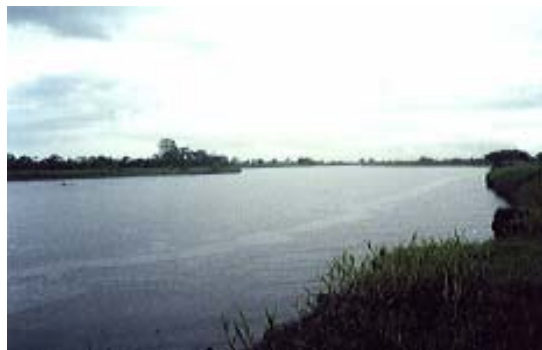
Foto N. 11, Cauce del Río Upía la deforestación de las riberas ha sido intensa, las alturas de los taludes es mínima, presenta alto grado de erosión, lo que facilita los desbordamientos, vereda Buenos Aires.
