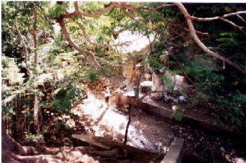
BARRIOS EN ZONAS DE ALTO RIESGO POR AMENAZA DE AVALANCHA (CAÑO EL HUECO)
