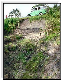
**FOTO 6:** Inestabilidad del terreno presente a 500metros de la entrada del casco urbano del municipio de Guavatá
