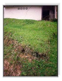
**FOTO 7:** Hundimiento del terreno que afecta las construcciones, debido al mal manejo de las aguas residuales y mal uso
