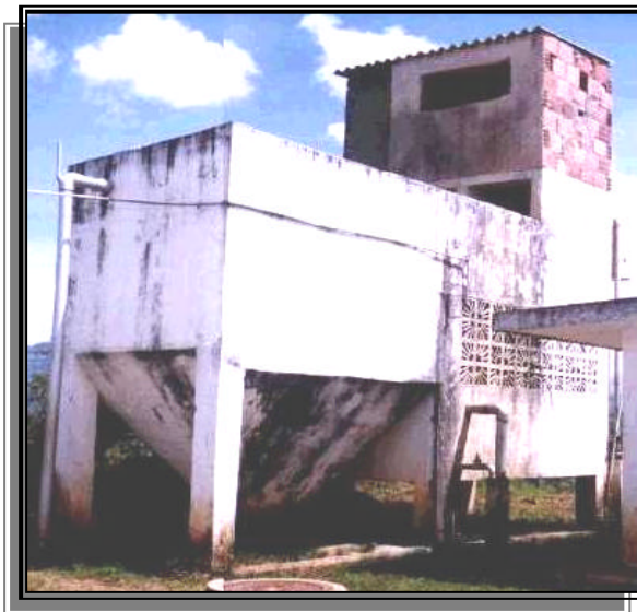
FOTO 5 – 6: Sedimentador y Filtro
