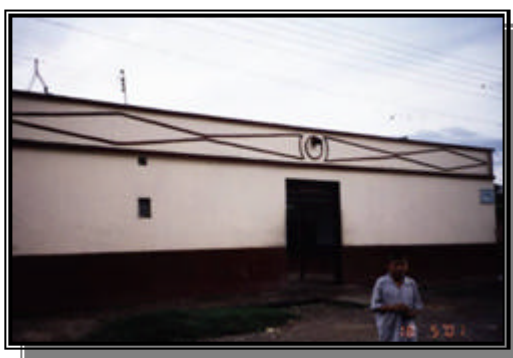
FOTO 10: Fachada del matadero y expendio de carnes.
