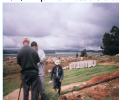
Foto 3: Trabajos para la construcción de vivienda de interés social. El Oasis, 2003.
